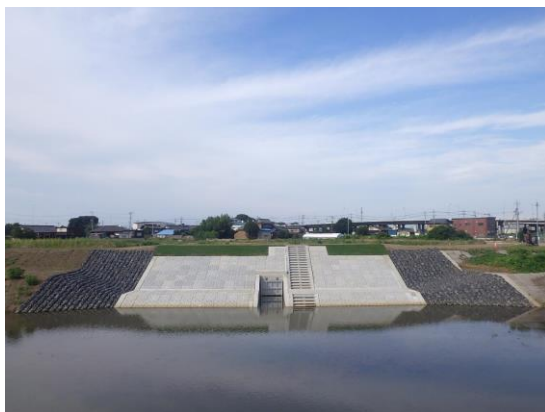
(排水ポンプ付き樋門)
