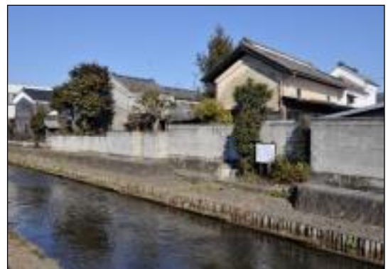
写真 巴波川沿いの土蔵群
