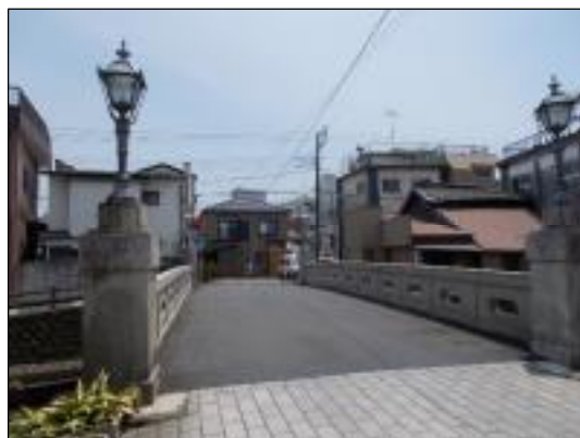
写真 ②倭橋 (昭和 5 年(1930))
