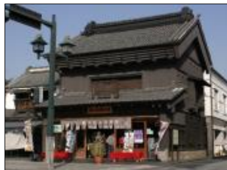
写真 とちぎ蔵の街観光館（旧田村家）
