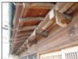
写真 出桁造
