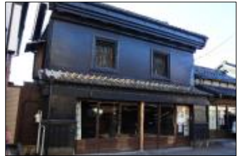
写真 大貫家（旧大貫定衛商店）
