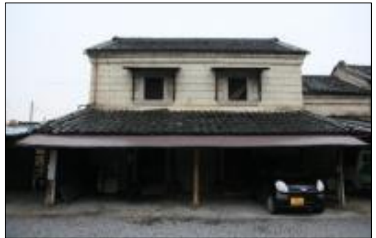
写真 b)-5 のじり 野尻家石蔵 [大正 15 年 (1926) 建築《墨書》] 伝統的建造物
