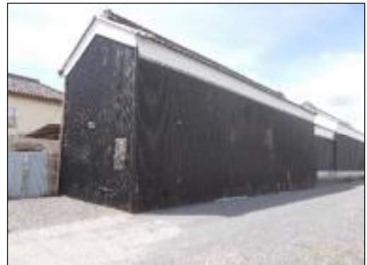
写真 本澤商店土蔵（東側）
