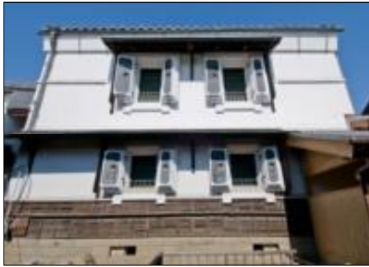
写真 b)-2 あぶでん 油伝味噌文庫蔵 (三階建) [明治 18 年 (1885) 建築《棟札》] 国登録文化財・伝統的建造物
