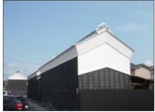
写真 本澤商店土蔵（西側）
