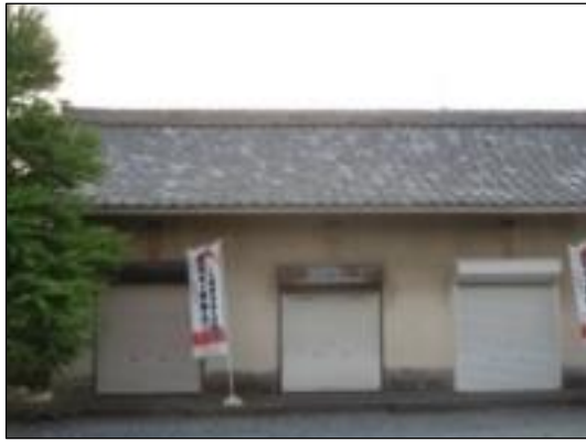
写真 神明宮境内の山車収納庫
