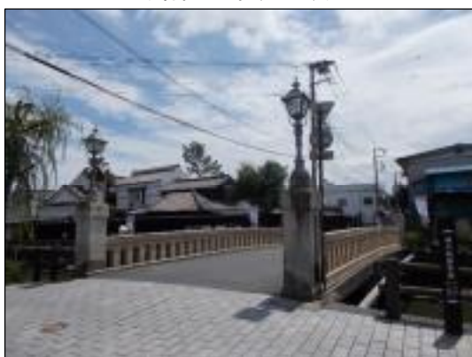
写真 ③巴波川橋 (昭和 9 年(1934))
