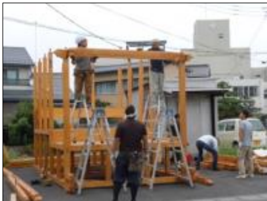
写真 仮殿の設営
