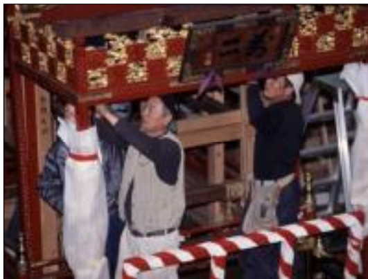
写真 山車の組み立て
