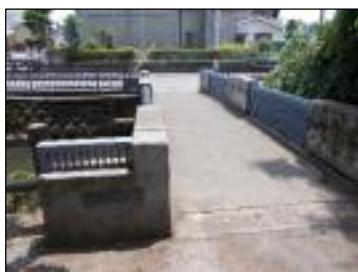
写真 ⑳栃木橋 (昭和 44 年(1969))
