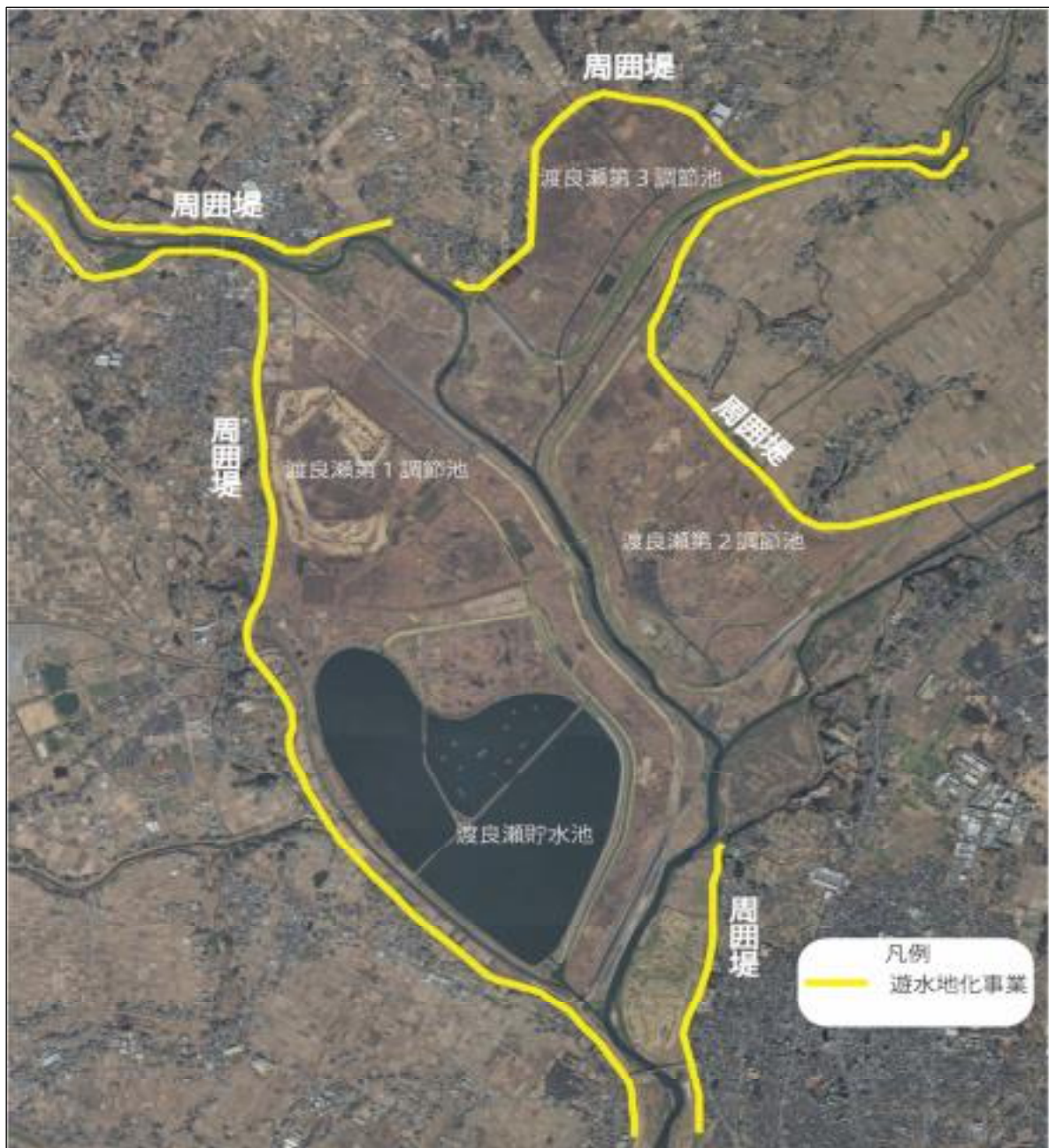
写真 遊水地化事業で築堤した周囲堤 (加工)
