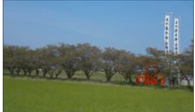
写真 巴波川の堤防 (奥が堤防)
