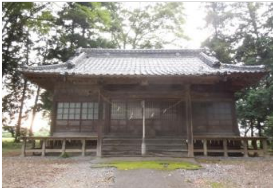
写真 造営された拝殿
