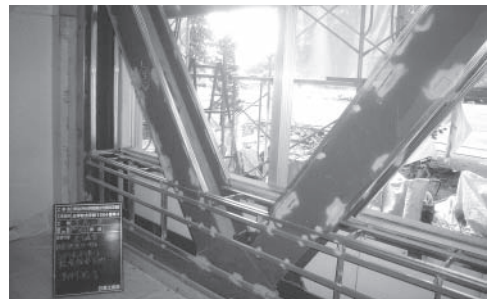
校舎の耐震補強工事
