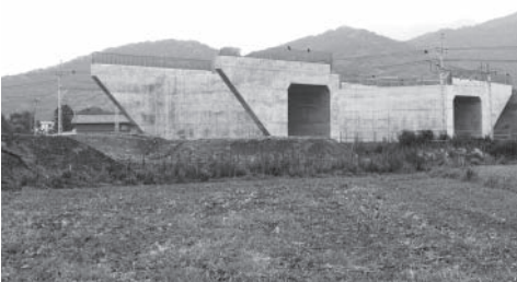
改築工事中の市道O157号線
