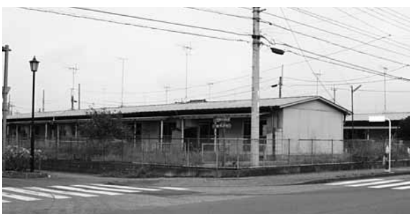
取り壊し予定の大平西水代市営住宅
