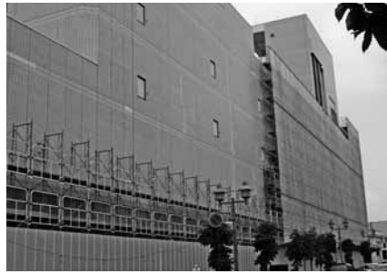
工事中の新庁舎
