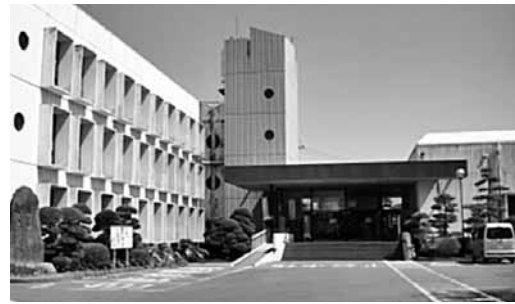
昭和46年建築の栃木市民会館
