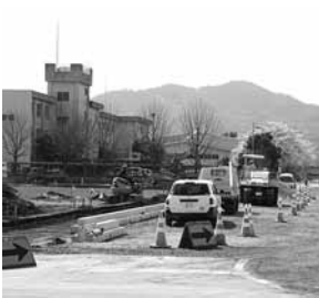
とちぎメディカルセンター第1病院(仮称)周辺の整備の様子
