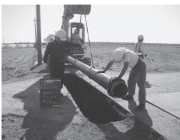
石綿管布設替工事の様子 (藤岡地域)
