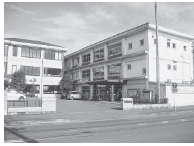
解体される旧岩舟町庁舎(写真右)
