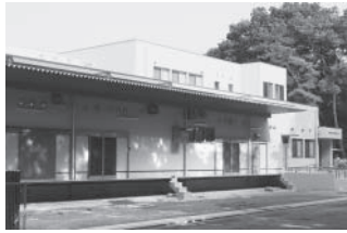
建設中の大平中学校給食センター
