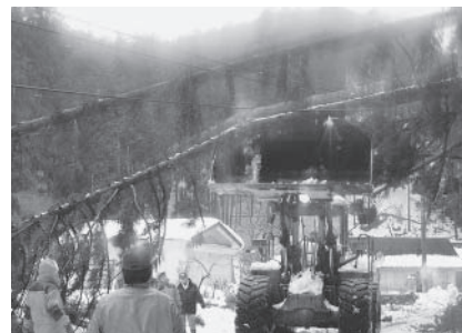
倒木の撤去作業(今年2月西方地域)
