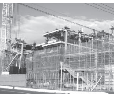
建設中のとちぎメディカルセンター第1病院
