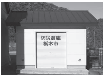
備蓄倉庫(寺尾公民館敷地内)
