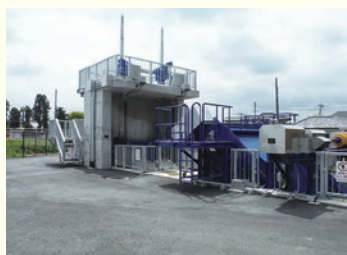
平井川排水施設 (令和7年2月完成)
