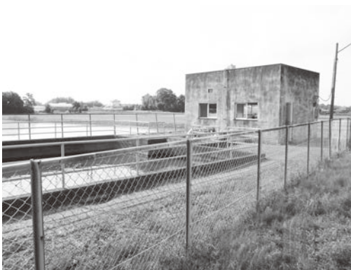
土地改良区の揚水施設
