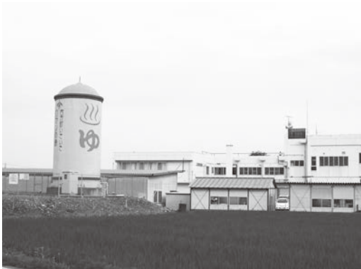
民間事業者所有の温泉施設(西方地域)
