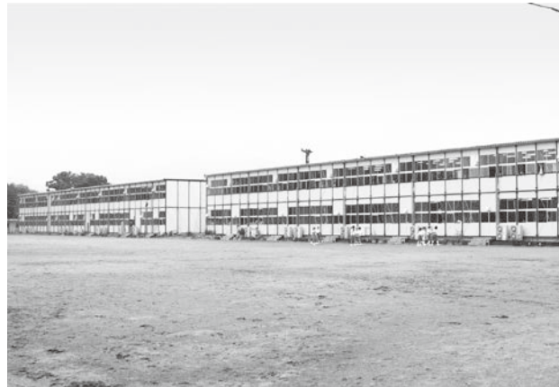
新校舎の完成を待ちながら仮設校舎で学ぶ大平中学校の生徒
