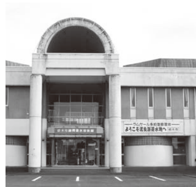
入口の段差解消等を行った遊水池会館
