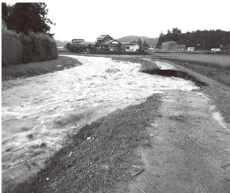
豪雨により川岸が崩れた逆川（都賀地域）
