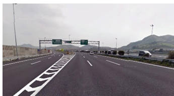
東北縦貫自動車道
