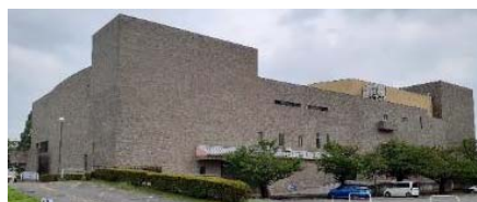
【外装改修(外壁タイル)】
