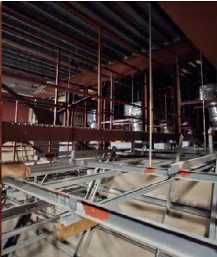
【現況大ホール天井裏(吊り天井)】
