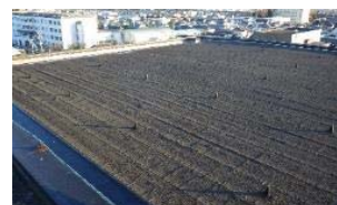
【外装改修(屋上防水)】
