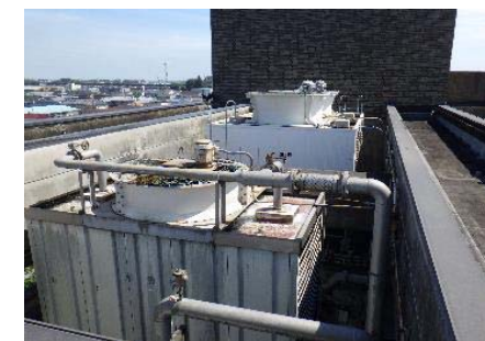
【既存クーリングタワー撤去】
