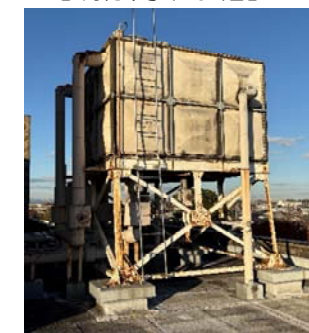
【既存高架水槽】
