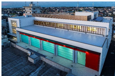
栃木市消防本部・消防署
