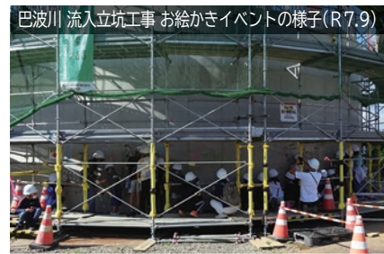
巴波川 流入立坑工事 お絵かきイベントの様子(R7.9)
