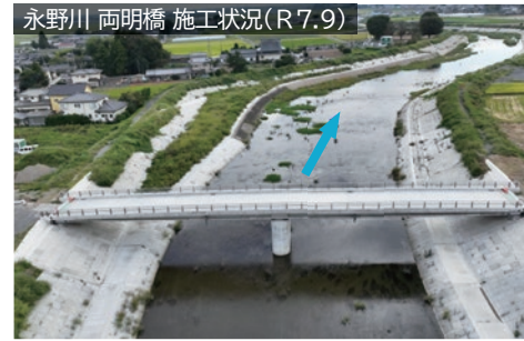
永野川 両明橋 施工状況(R7.9)
