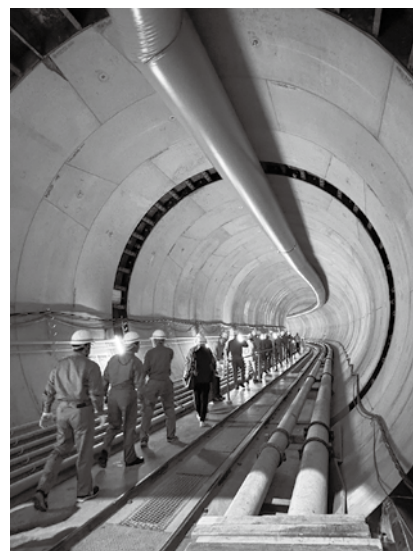
トンネル坑内の見学の様子
