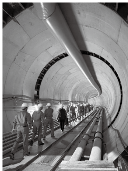
トンネル坑内の見学の様子
