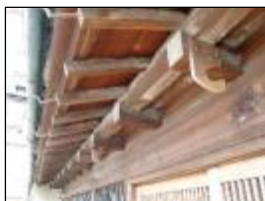
写真 出桁造
