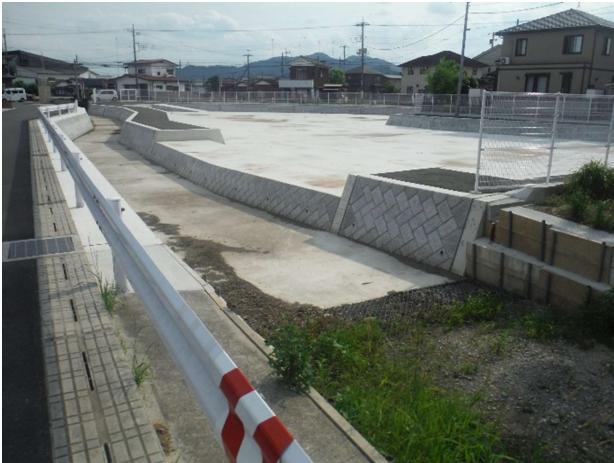
③旧赤津川第2調節池
