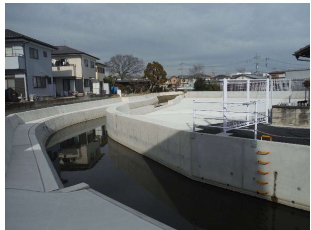
②旧赤津川第1調節池
