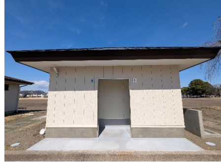
〔栃木市総合運動公園の屋外トイレを更新〕
