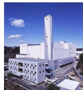
〔とちぎクリーンプラザ〕 (単位：kwh)
