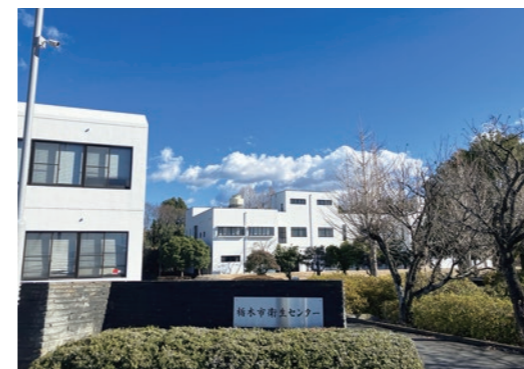
衛生センター
