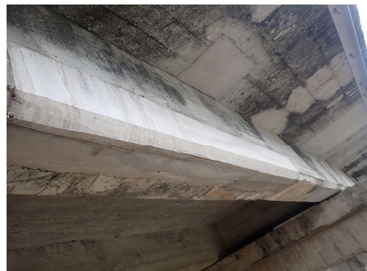
補修を行い、供用を継続
