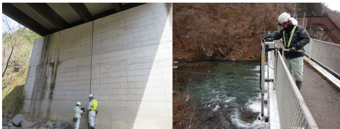
図4 カメラ撮影による定期点検支援技術の例
