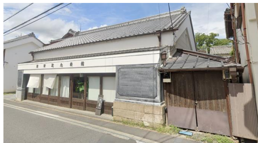
出店準備中の修理を終えた伝統的建造物(岡田家)
