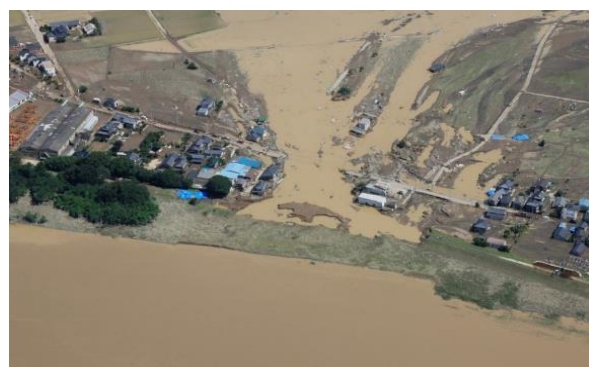
堤防決壊による家屋の流失(鬼怒川)
