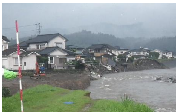
河岸侵食による家屋の倒壊(花月川)
