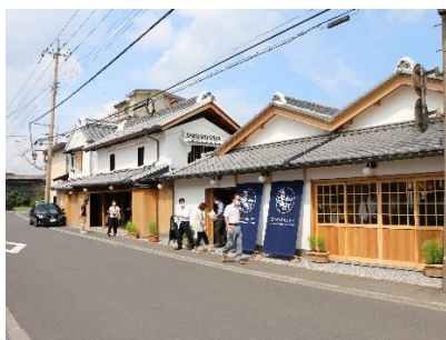
栃木市嘉右衛門町伝建地区拠点施設 「ガイダンスセンター」
