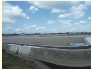
東郷堀川調節池 (令和 7 年 9 月完成)
