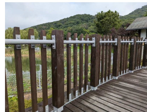
道の駅みかもレストランデッキ改修
