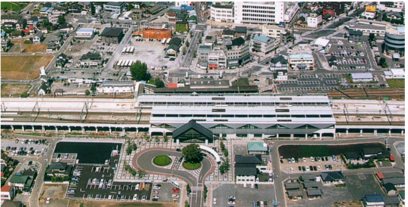
【 整備された栃木駅南口駅前広場と整備中の栃木駅周辺連続立体交差事業 】
