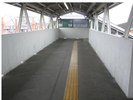
跨線橋の橋上部
