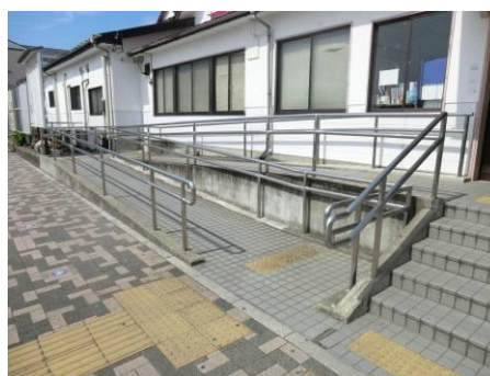
車いす用スロープ
