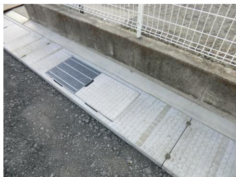
側溝への改善による歩行スペースの確保例（旭町地内）
