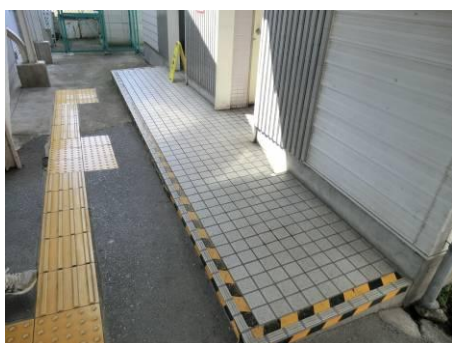
トイレ出入口
