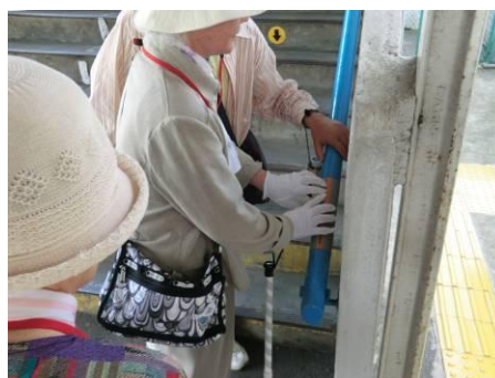
跨線橋の階段手すり
