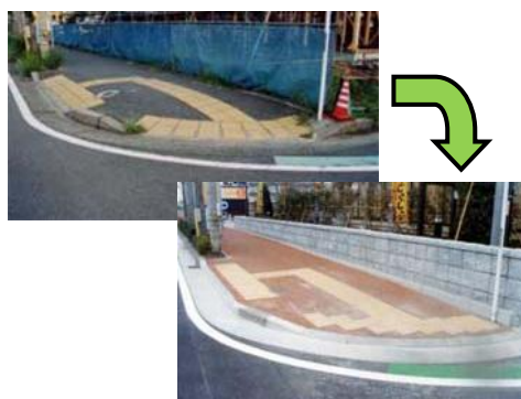
歩道の段差改善例
