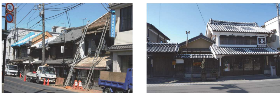
写真 3.5.1 東日本大震災での被害が軽微だった事例
