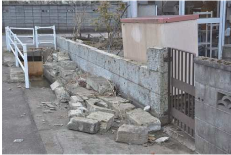
写真 3.5.7 地震による石塀の倒壊
