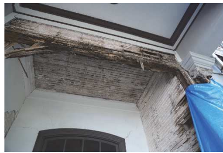
写真 3.5.6 洋風木造建築の耐久劣化事例
