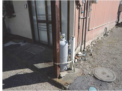
写真 3.5.8 沿道に設置されたプロパンガス
