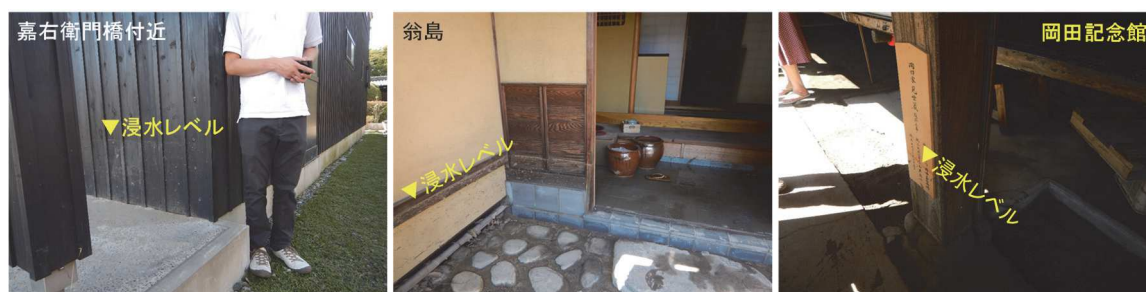
写真 3.6.1 伝建地区の浸水状況
