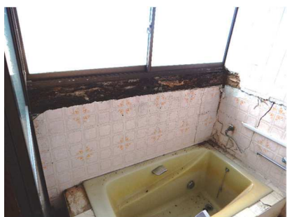
写真 3.5.5 水回りの劣化事例
