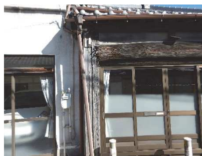
写真 3.5.4 外観目視調査で確認した劣化事例
