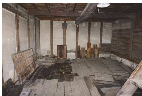
写真 3.5.3 水害で部材劣化が進行する事例
