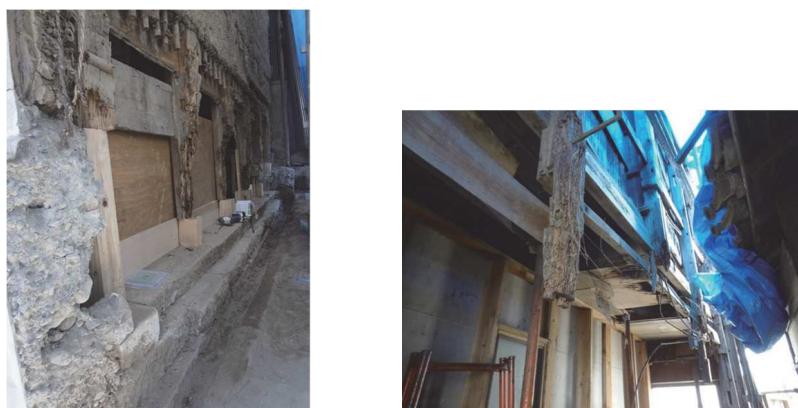
写真 3.5.2 被災や工事解体で発覚する損傷事例
