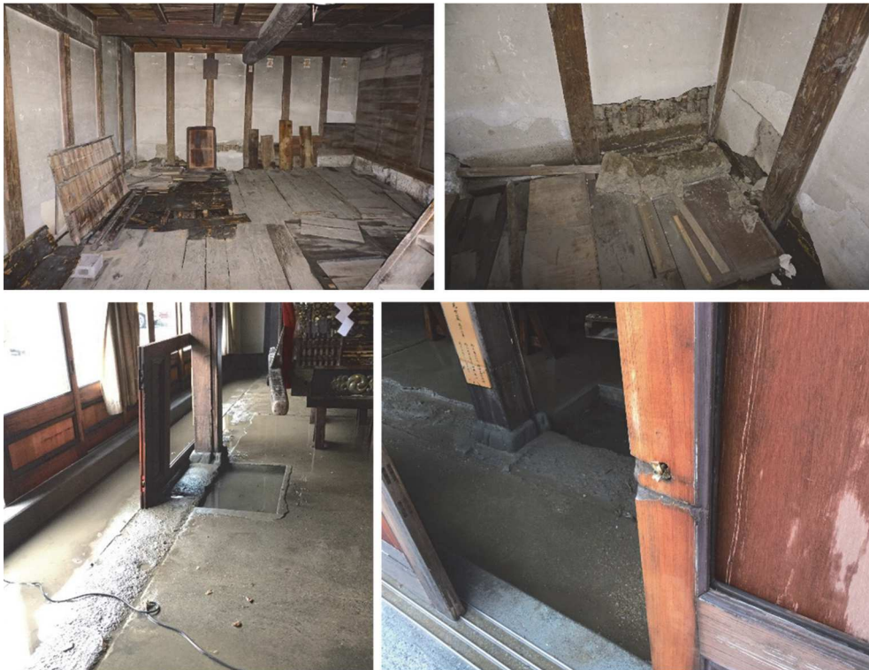
写真 3.6.2 伝統的建造物の被害の様子
