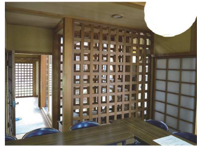
写真 4.3.4 面格子壁による補強
