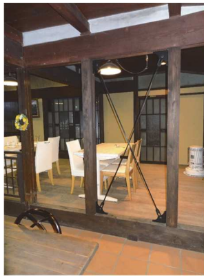
写真 4.3.3 鋼製ブレースによる補強
