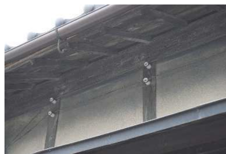
写真 4.2.3 昔のままの電気配線を使用する建物
