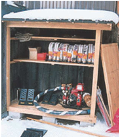
写真 4.2.7 D級ポンプの格納箱の一例
