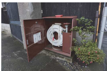
易操作性1号消火栓 (桜川市真壁地区)
