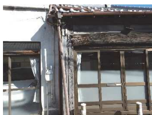
木造家屋の梁の劣化
