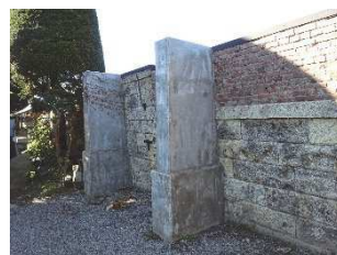
組積塀の補強事例
