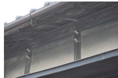
昔のままの電気配線を使用する建物
