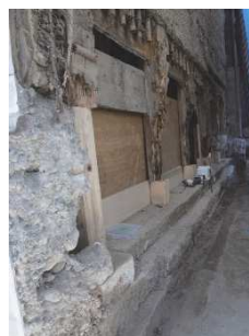
土蔵の柱脚・土台の劣化
