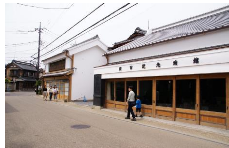
修理後の建造物
