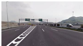
東北縦貫自動車道
