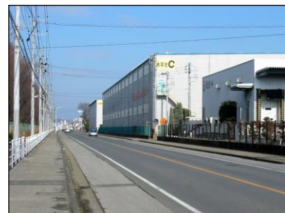
幹線道路沿道の産業系施設
